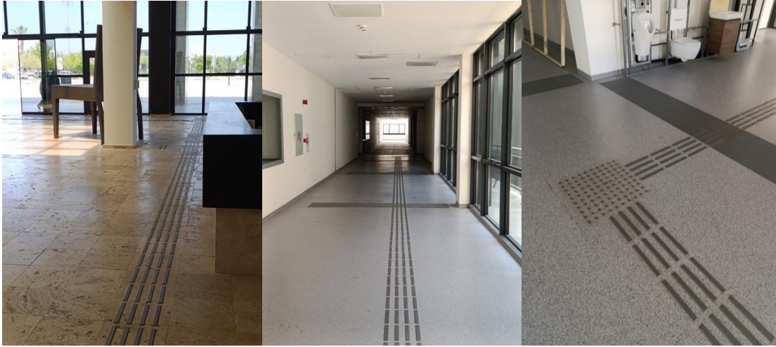
Şekil 97: Okulumuz giriş ve koridorlarında bulunan hissedilebilir yüzeyler
