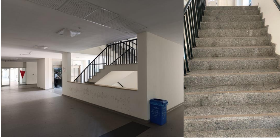
Şekil 98: Okulumuzdaki düşey sirkülasyon çekirdeği ve merdiven basamaklarındaki kaydırmaz bantlar
