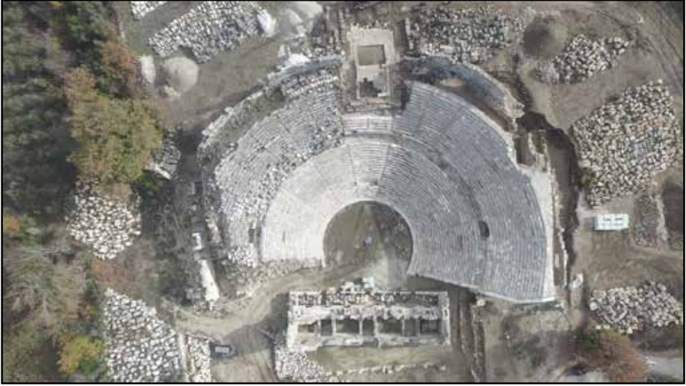
Resim 10: Tiyatro Restorasyonu Aralık 2024.
