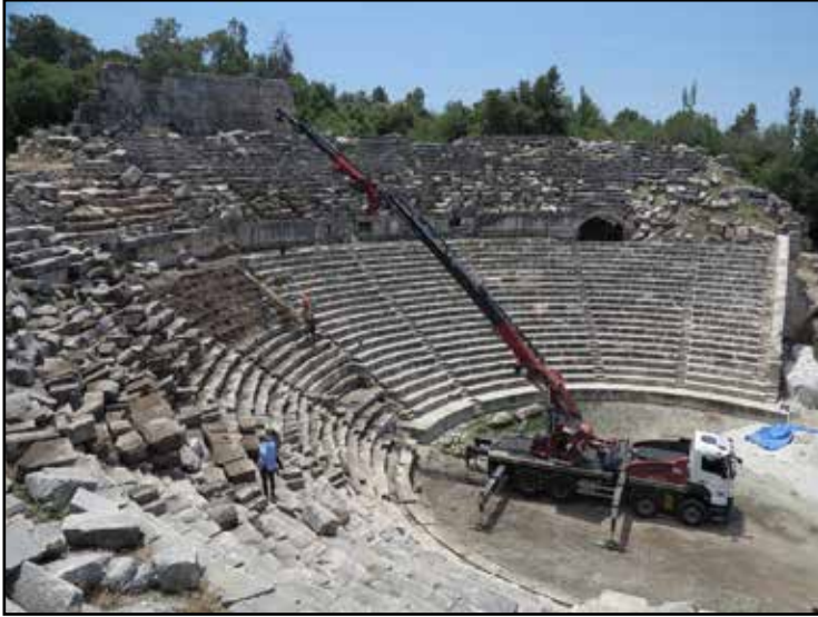
Resim 9: Oturma sıraları söküm çalışmaları.
