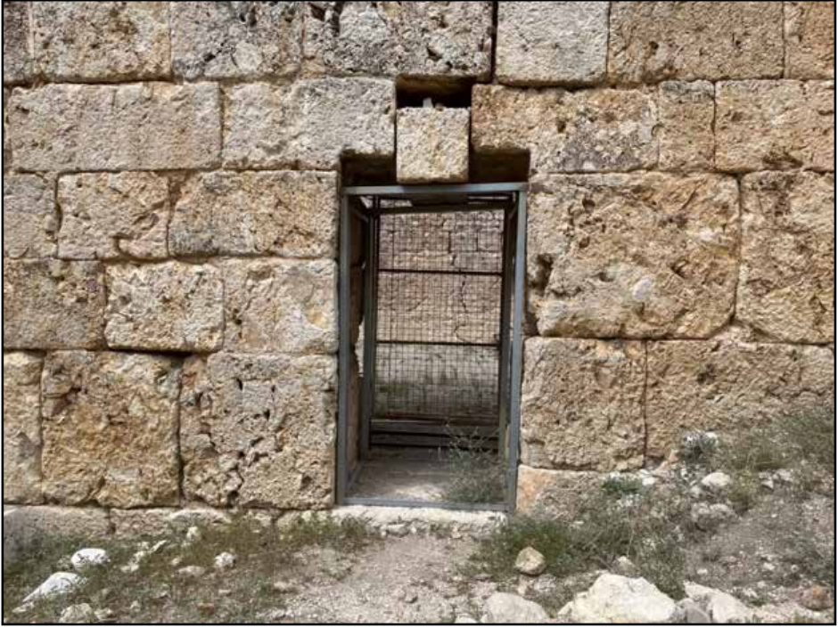
Resim 13: Büyük hamam frigidarium kapı çelik destek.
