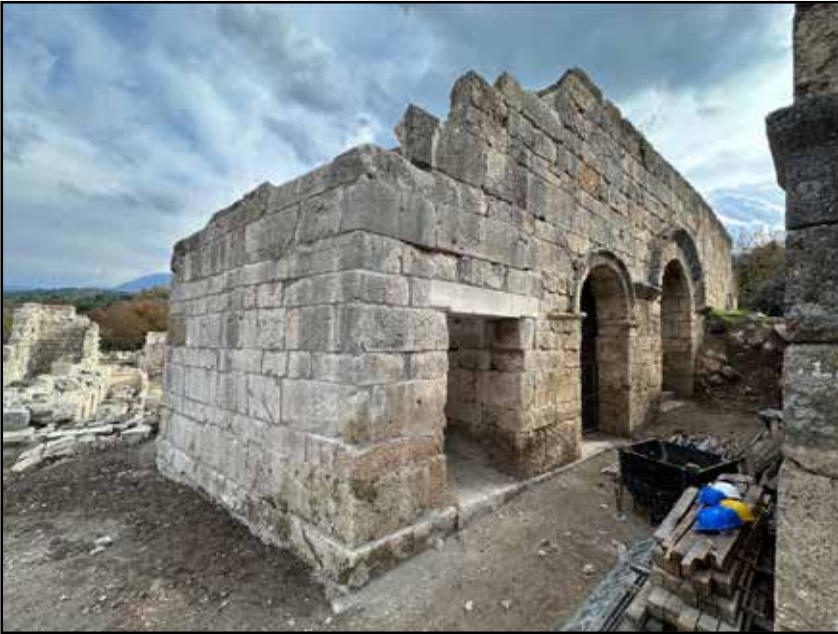
Resim 12: Oda 1 restorasyon çalışmaları.
