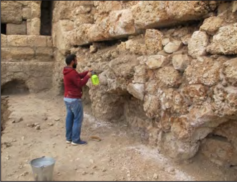
Resim 14: Mimari onarım ve konservasyon çalışmaları.
