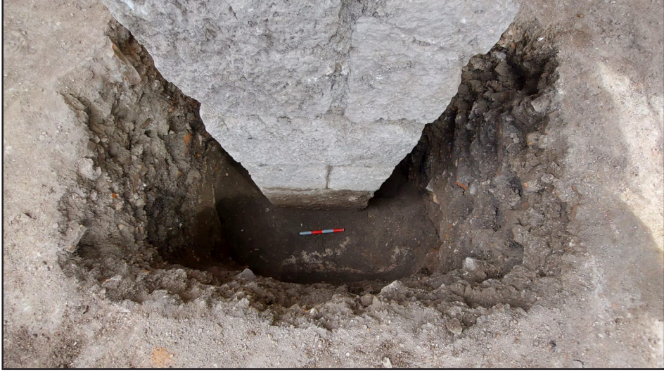
Resim 11: Exedra tonoz ayağı zemin.
