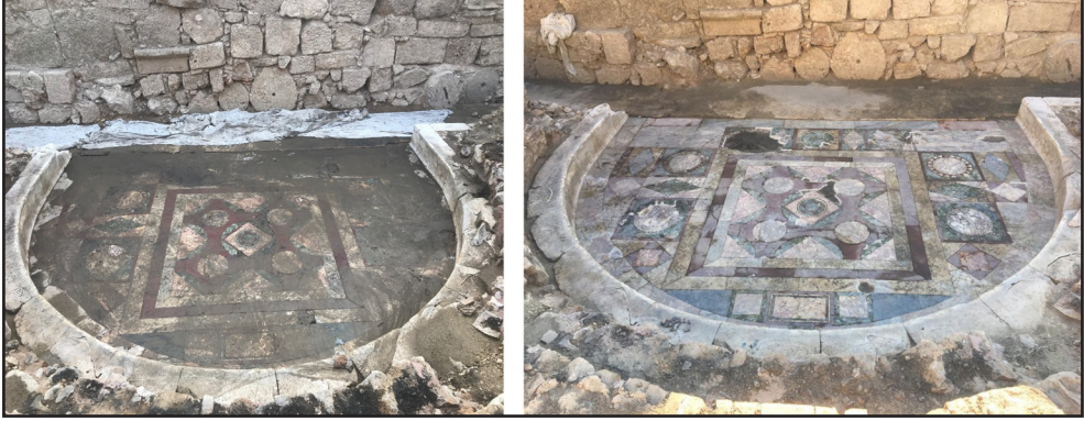
Resim 15: Meclis Binası Orkestra konservasyon öncesi-sonrası.
