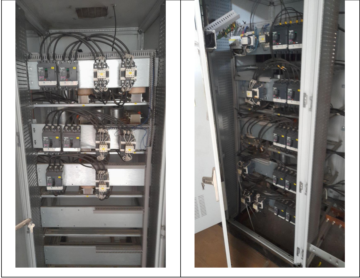
Resim 6-75 Kompanzasyon Sistem Görüntü Örnekleri
