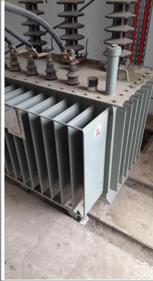
Resim 6-3 Meltem Dağıtım Merkezi Trafo
