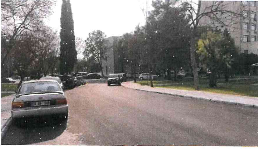
Rektörlük binası yol, yağmur suyu hattı ve çevre düzenleme çalışmaları
