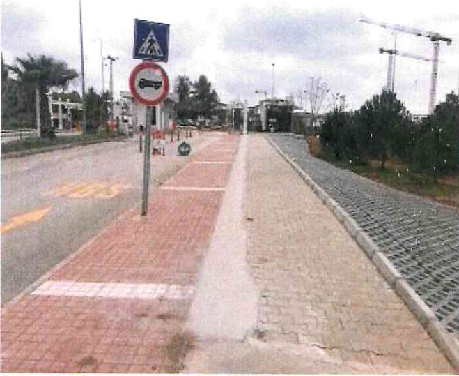
Yaya Yolları, Engelli Yol Bordürü çalışmaları
