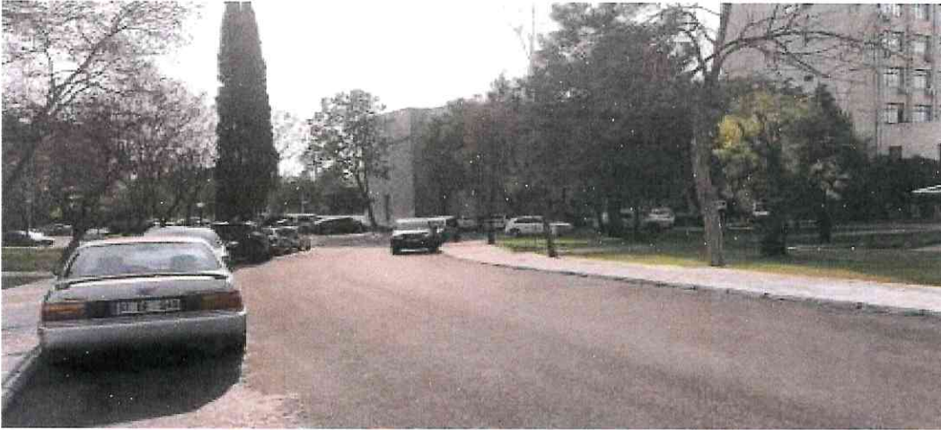
Rektörlük binası yol, yağmur suyu hattı ve çevre düzenleme çalışmaları
