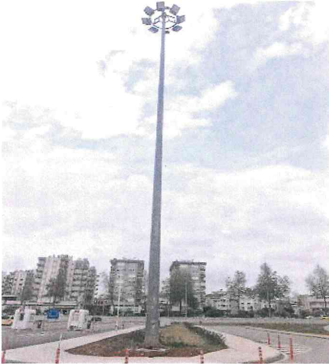
25 metrelik asansörlü aydınlatma direği işleri
